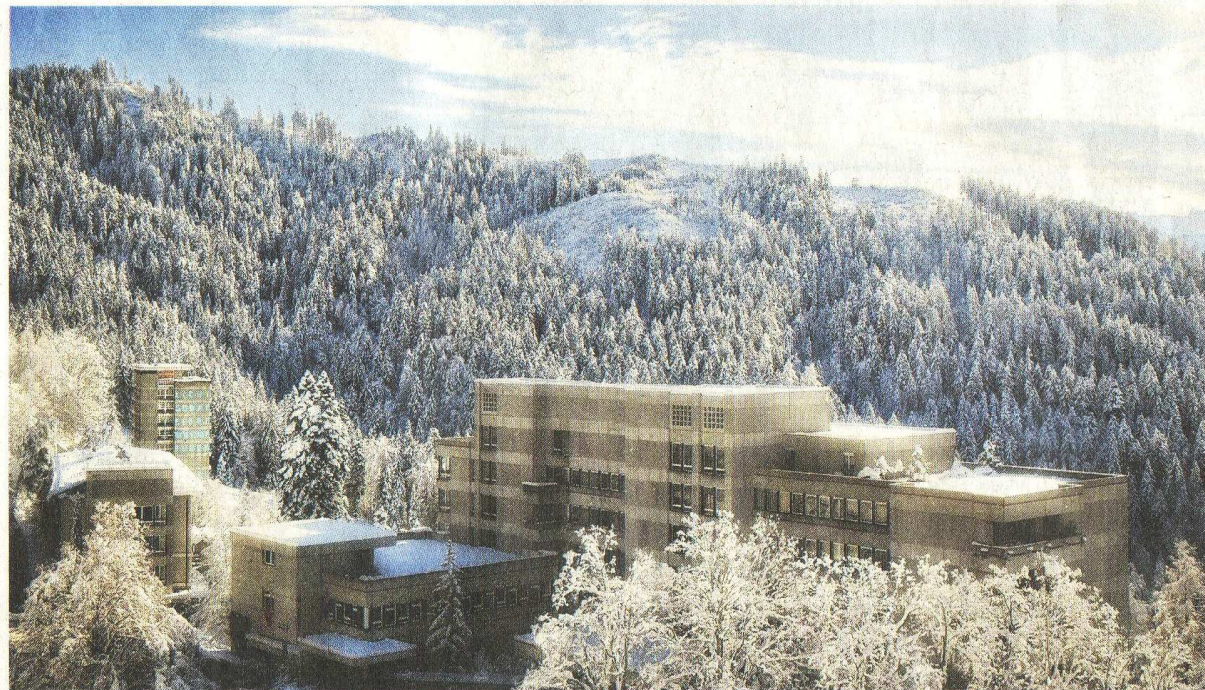
Das Berner Rehazentrum Heiligenschwendi im Schneeschleier. Die grosse Hauptklinik (rechts im Bild) wird ab Sommer 2012 saniert.
